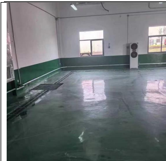
危废库导流沟集液槽
