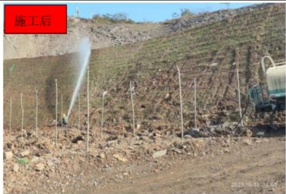
西北部 55m 平台上的排水沟、覆土绿化
