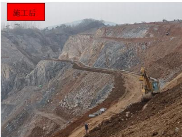
西北部 55m 平台上的排水沟、覆土绿化
