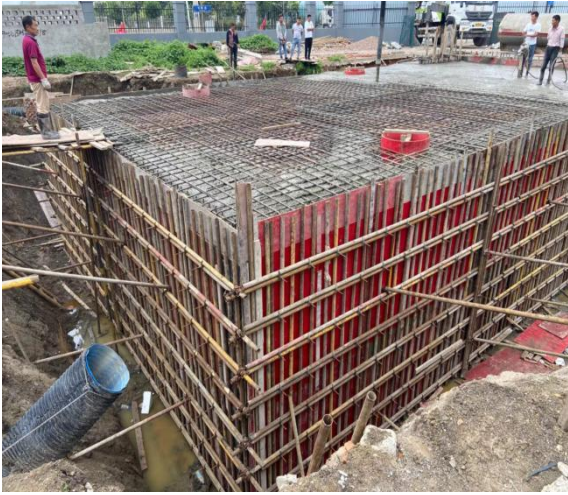
事故应急池及初期雨水池施工照片
