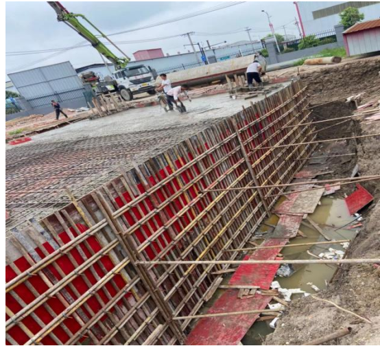
事故应急池及初期雨水池施工照片
