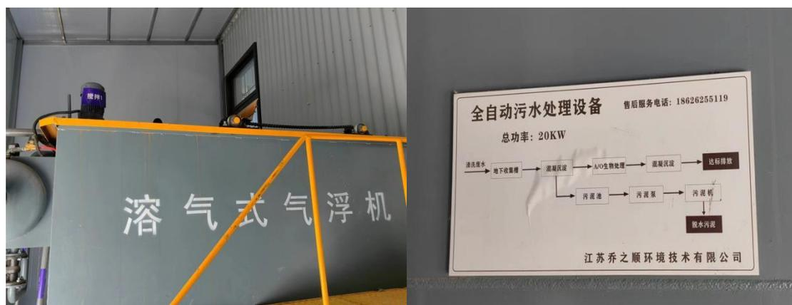
厂区污水处理站及工艺流程图
