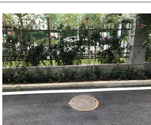
厂区污水排口
