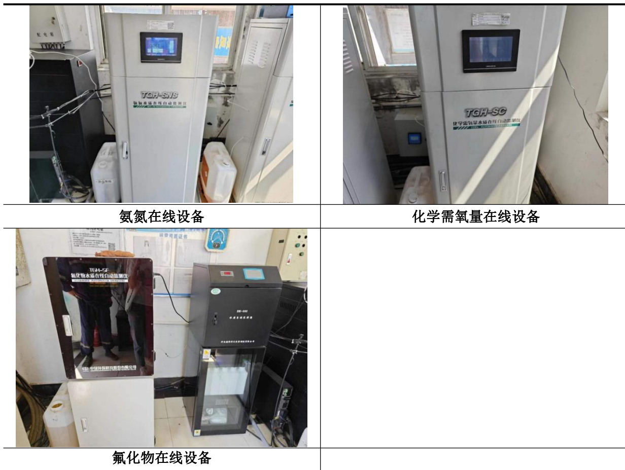
图 15.2-2 废水总排口在线设备照片
