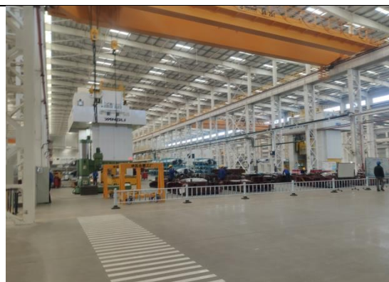
1#厂房 (冲压车间)
