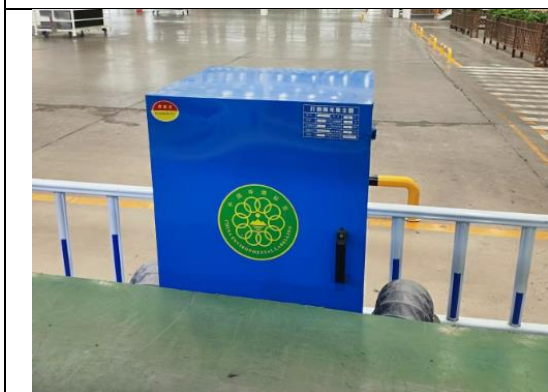
返修打磨仅打磨钢板、配备除尘器
